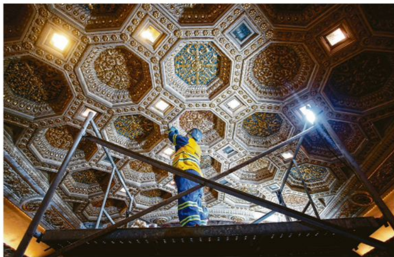
Beleza por todo lado. O trabalho de restauração do Palacete do Parque Lage está revelando o teto original do cômodo ocupado hoje pela biblioteca da EAV
