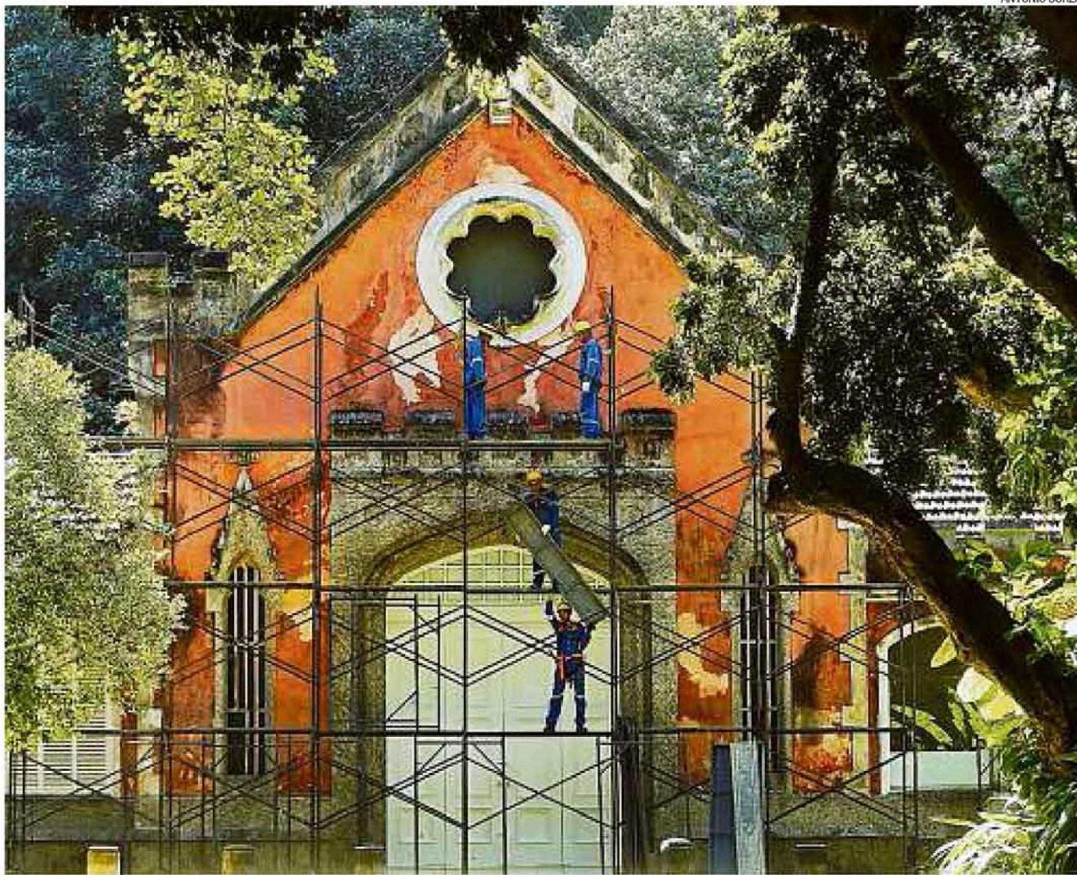
Em serviço. Operários montam andaime para a pintura das cavalariças: projeto foi aprovado pelo Iphan, e trabalhos deverão durar 30 dias
